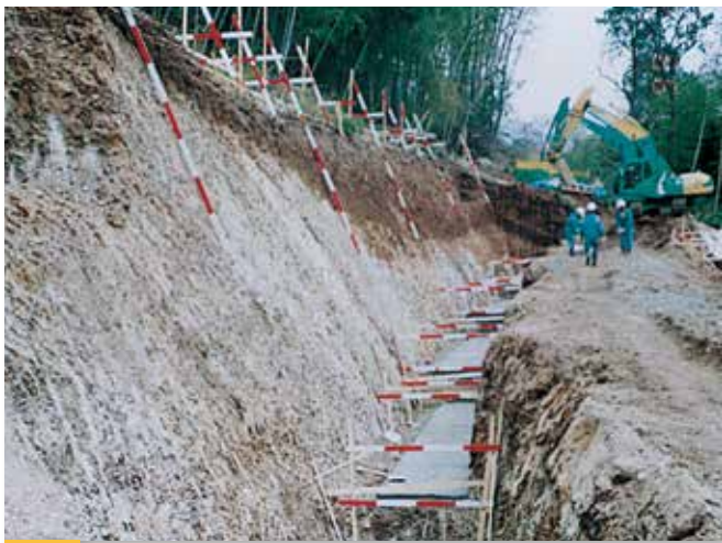
1 掘削・均しコンクリート打設
