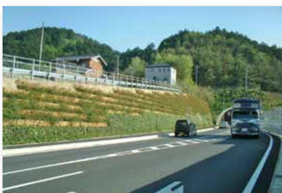
岐阜県高富町 国道256号線 高木トンネル
