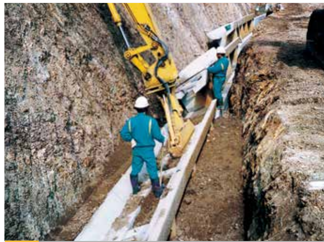
4 中込土・裏込土投入・転圧(現場発生土・良質土を使用します)
