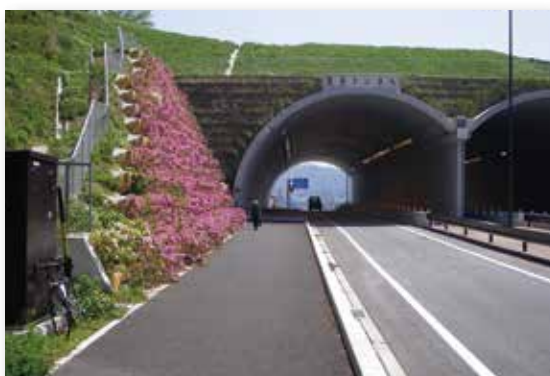
愛知県蒲都市 国道247号線
