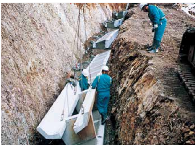
3 エバーグリーン本体据付 (施工勾配をつけて4点吊りにします)
