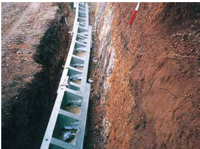
2 基礎ブロック据付 (中込コンクリートを打設します)
