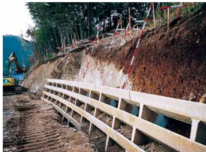
5 1段ごとに転圧を行い、積んでいきます。
