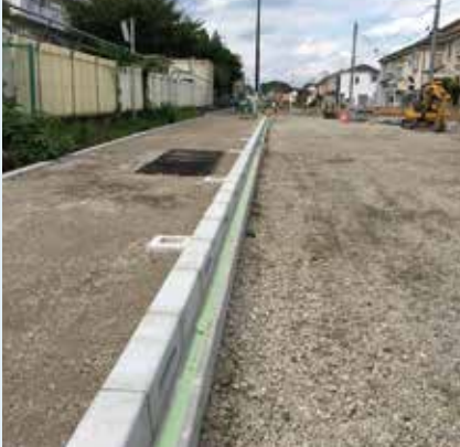
東京都東久留米市 都計道3・4・20号線(工事中)
