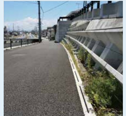
和歌山県和歌山市 南港山東線
