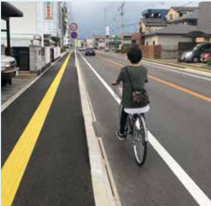
静岡県静岡市 上川原広野線
