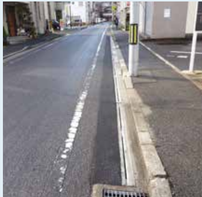
愛知県豊田市 道路維持修繕工事
