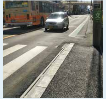
神奈川県横浜市 管内道路整備工事
