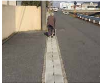
現場打ち側溝
