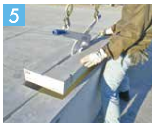
インバートコンクリートの打設作業後、パッキンを貼り専用吊金具にて頂版の据付
