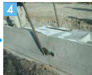
パーフェクトジョイント工法により製品を引寄せ、連結完了
