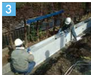
専用吊金属にて製品の据付
