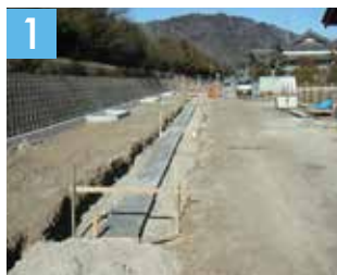
掘削をし、コンクリート基礎を打つ
