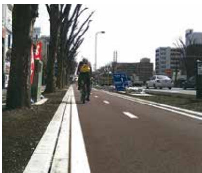
自転車道整備 国道16号 神奈川県相模原市
