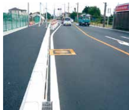
道路幅員の確保 埼玉県川口市
