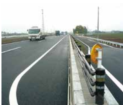
国道4号 埼玉県幸手市
