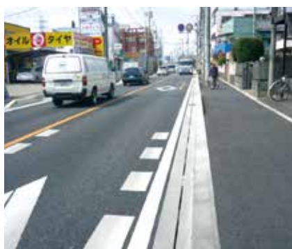
歩道整備事業 埼玉県朝霞市
