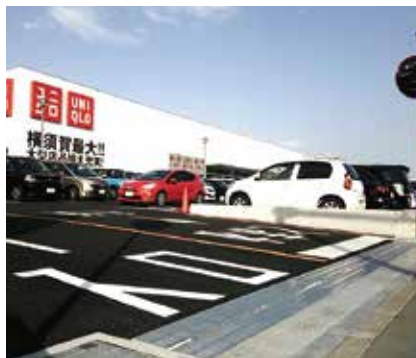
店舗乗入口 神奈川県横須賀市
