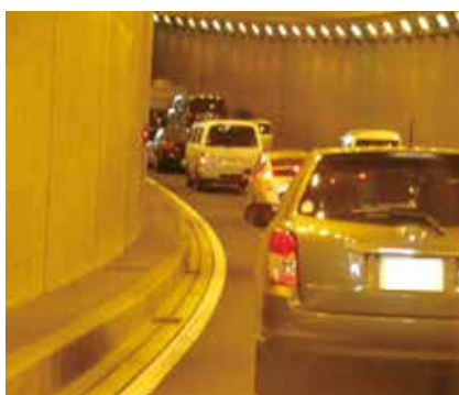
立体交差事業 神奈川県横浜市
