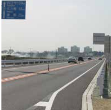
愛知県豊橋市(国道23号)
